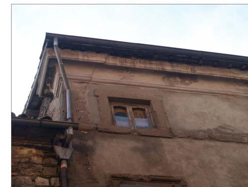
Gronde composite con moraletti di legno e pannelle e sottostante cornice in laterizio ricoperto con intonaco
